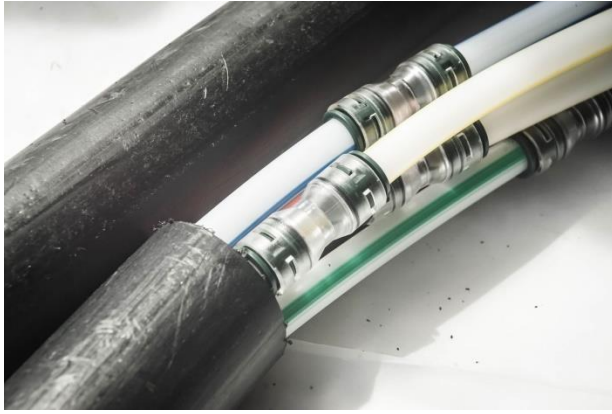
Slika 5.7: Rezultat spajanja mikrocijevi
