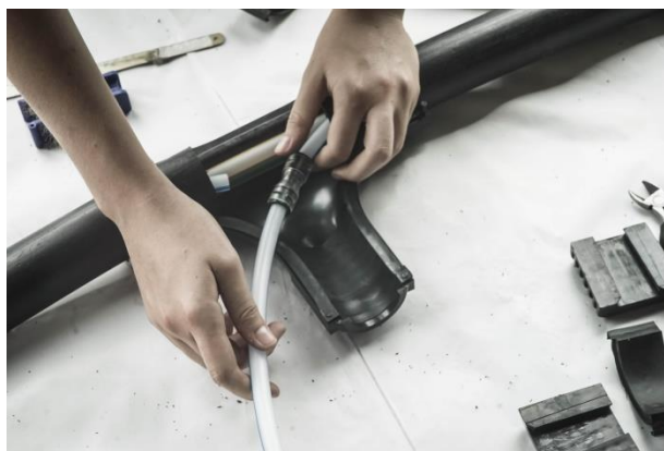
Slika 5.17: Spajanje mikrocijevi konektorom za mikrocijevi
