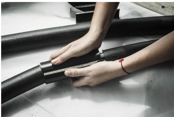
Slika 5.9: Postavljanje reparaturne sklopive cijevi
