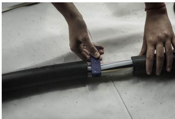
Slika 5.15: Presjecanje mikrocijevi na koju će se korisnik spojiti
