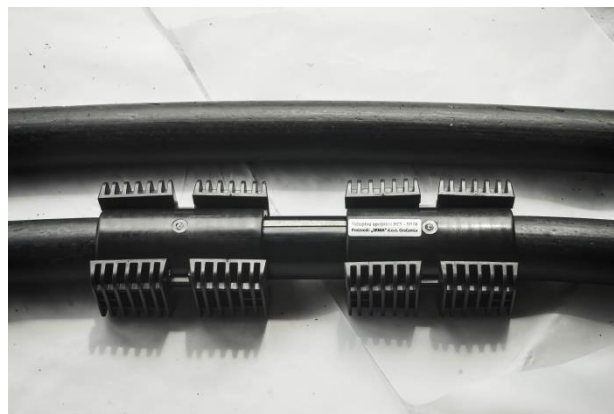
Slika 5.13: Reparirana PE50 cijev s uvučenim mikrocijevima
