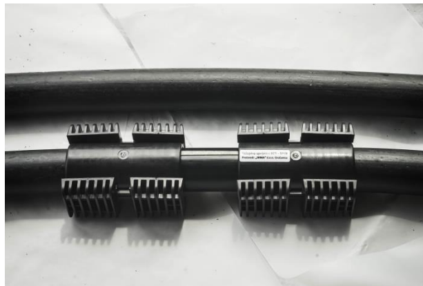
Slika 5.13: Reparirana PE50 cijev s uvučenim mikrocijevima
