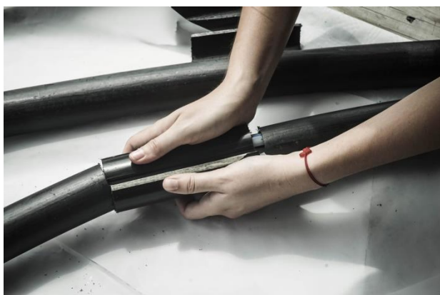
Slika 5.9: Postavljanje reparaturne sklopive cijevi
