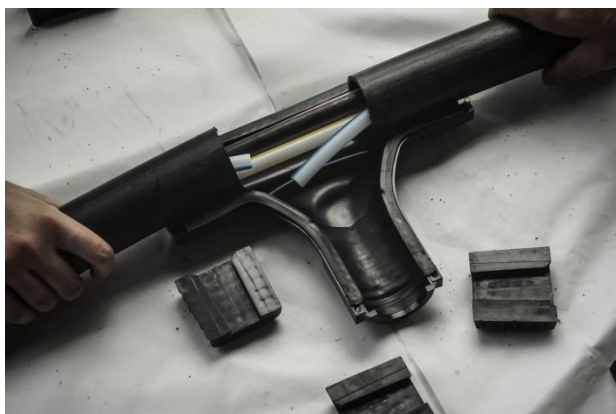
Slika 5.16: Postavljanje T konektora
