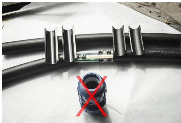
Slika 5.8: Reparacija cijevi isključivo reparaturnim kompletom
