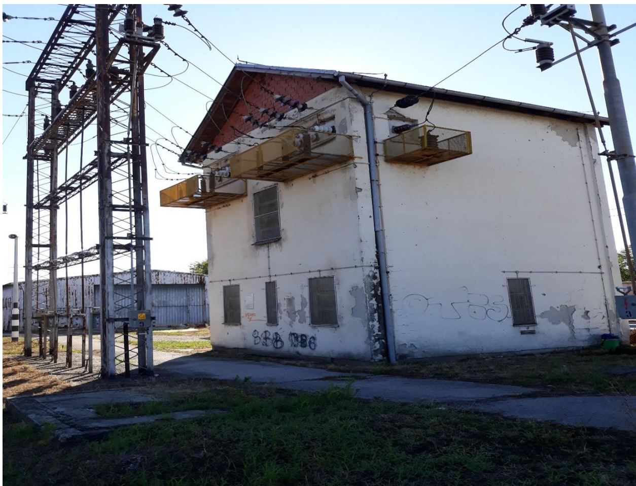
Slika 3.2 Stvarni izgled elektrovučne podstanice[6]
