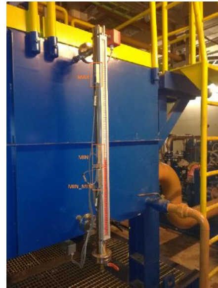
Slika 2.32. Mjerac razine ulja u industriji
