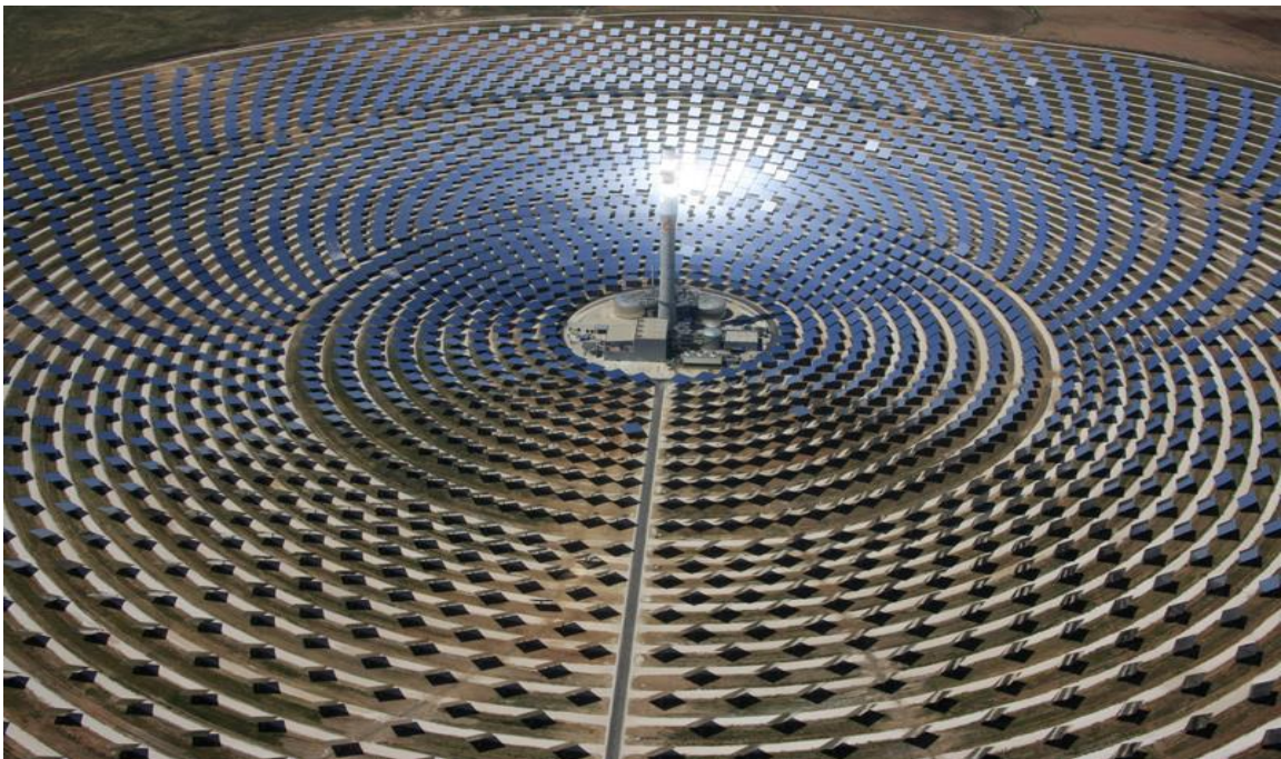
Slika 3.5. Gemasolar u Španjolskoj, (15 sati apsorbira sunčevu energiju, a 24 sata daje električnu energiju)
