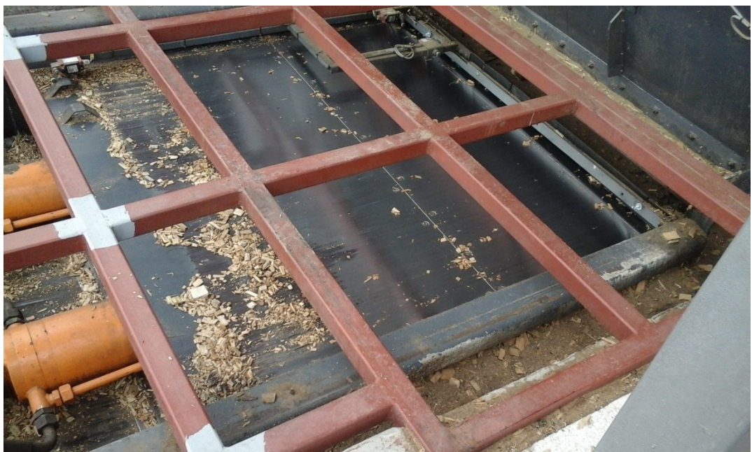
Slika 3.8. Uređaj za doziranje ubacuje sječku u kotao
