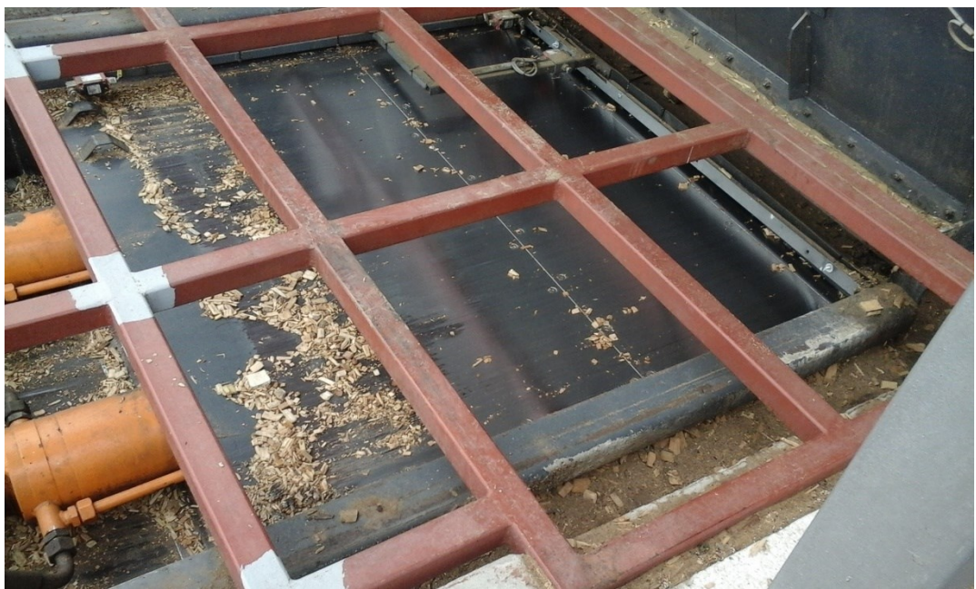
Slika 3.8. Uređaj za doziranje ubacuje sječku u kotao
