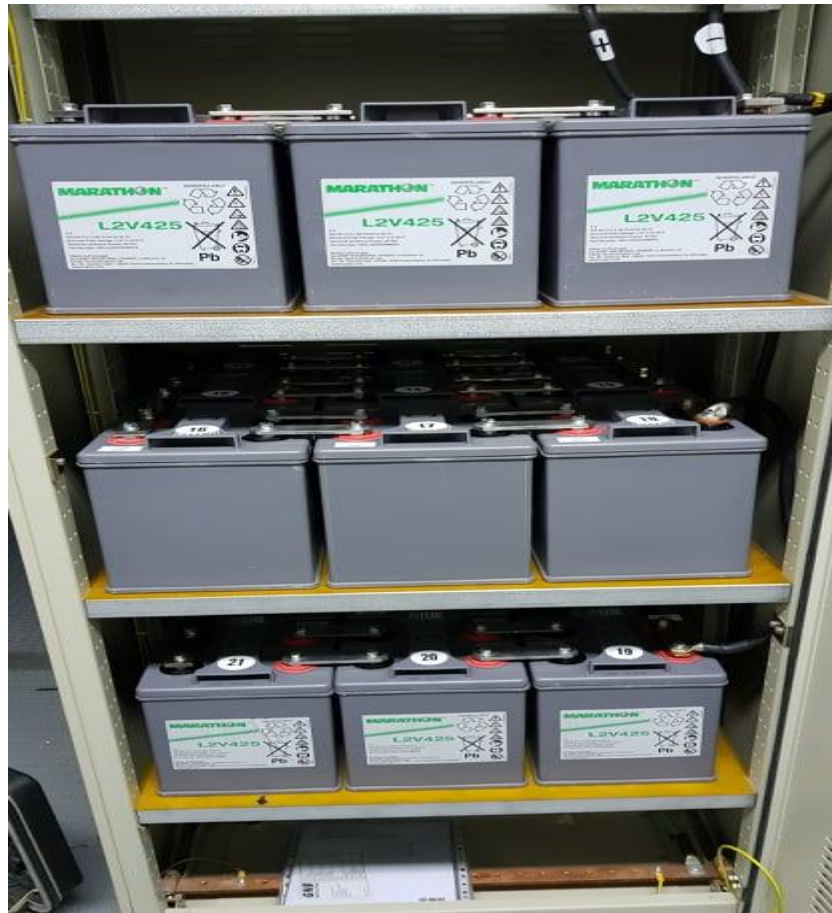
Slika 3.4. VRLA baterije
