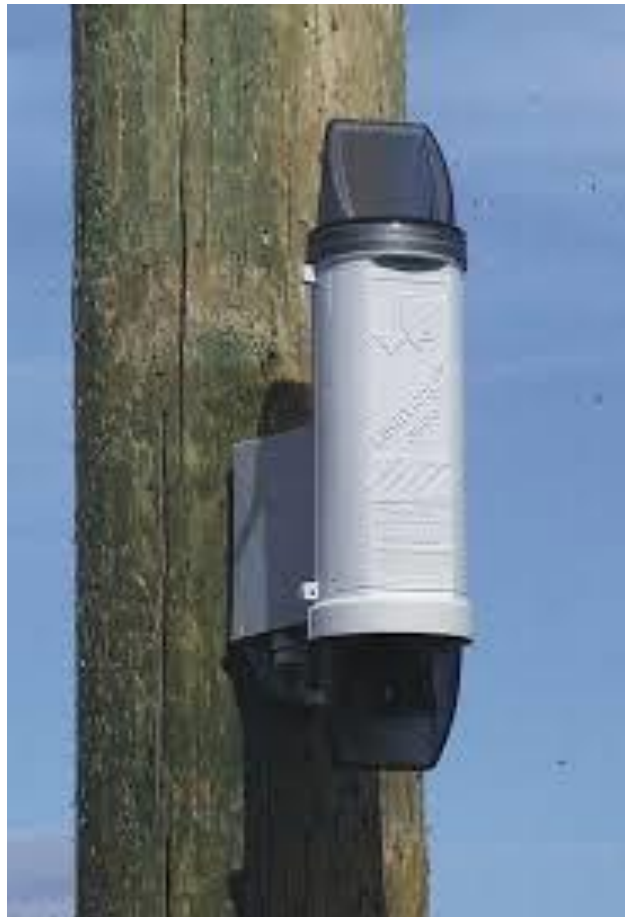
Slika 5. Indikator kvara LineTroll R400D [4]
