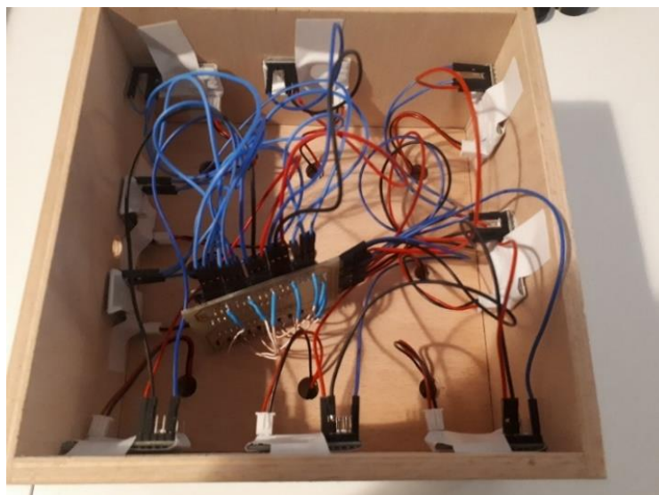
Slika 3.19. Kućište ispunjeno svom potrebnom elektronikom
