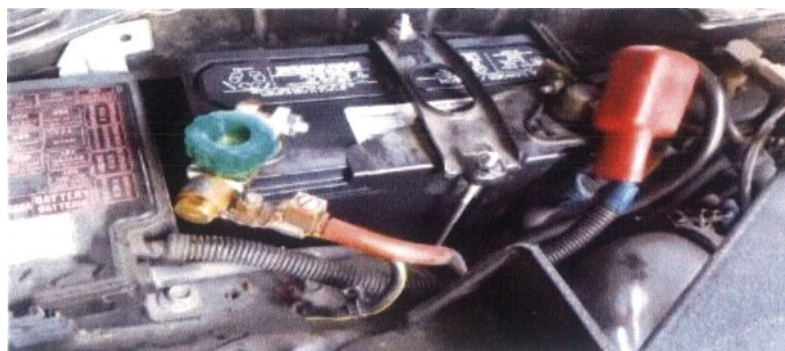
Slika 3.3.1. Ugradnja prekidača za automobilski akumulator
