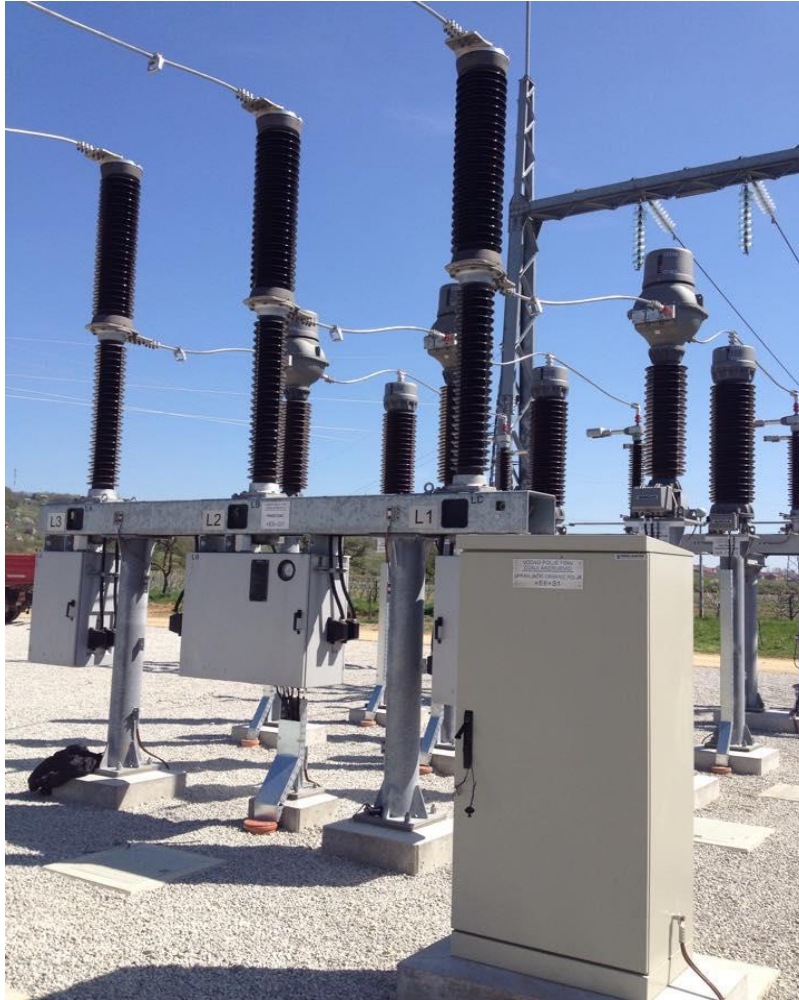
Slika 3.3. SF 6 prekidač u TS Sl. Brod 1, vodno polje Donji Andrijevci
