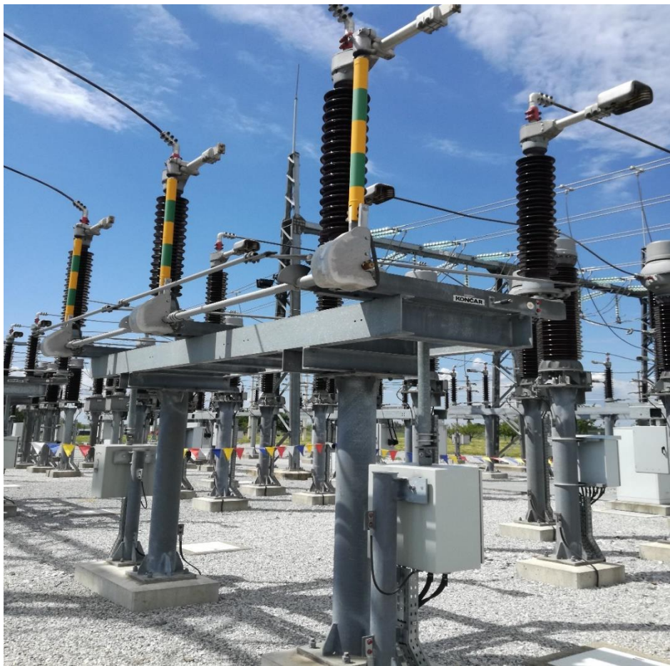
Slika 3.4. Dvostupni okretni rastavljači sa zemljospojnicima
