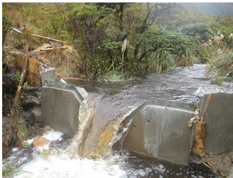
Slika 6.3.4. Trokutasti preljev na vodotoku [26]
