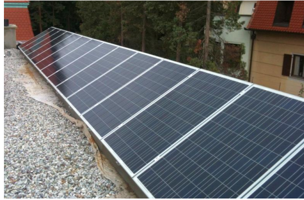
Slika 2.9. Fotonaponski niz(modul je samo jedna od tih ploča) [6]
