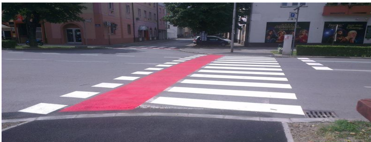
Slika 2.1. Primjer biciklističko-pješačkog prijelaza uz pravokutnu i paralelogram izvedbu.
