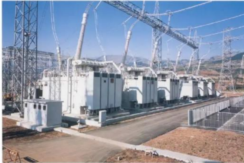
Slika 3.8. Jednofazni autotransformator 500 MVA [10].
