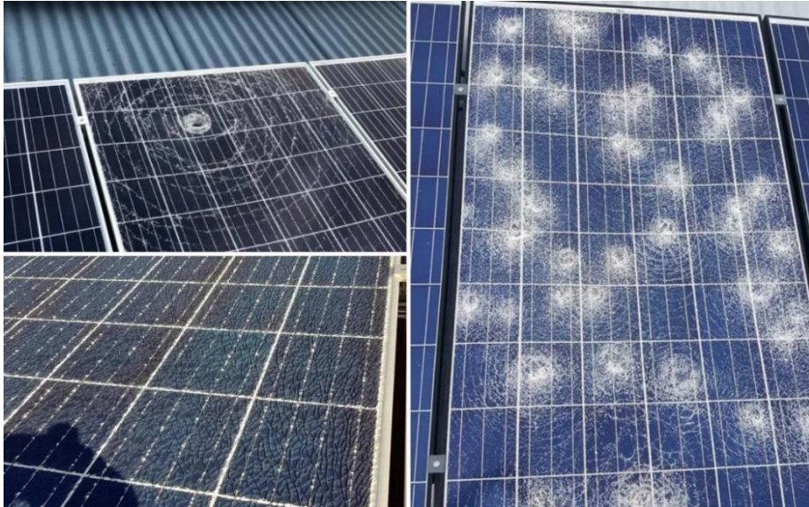
Sl. 3.10. Puknuće stakla uzrokovano elementarnim nepogodama [29].
