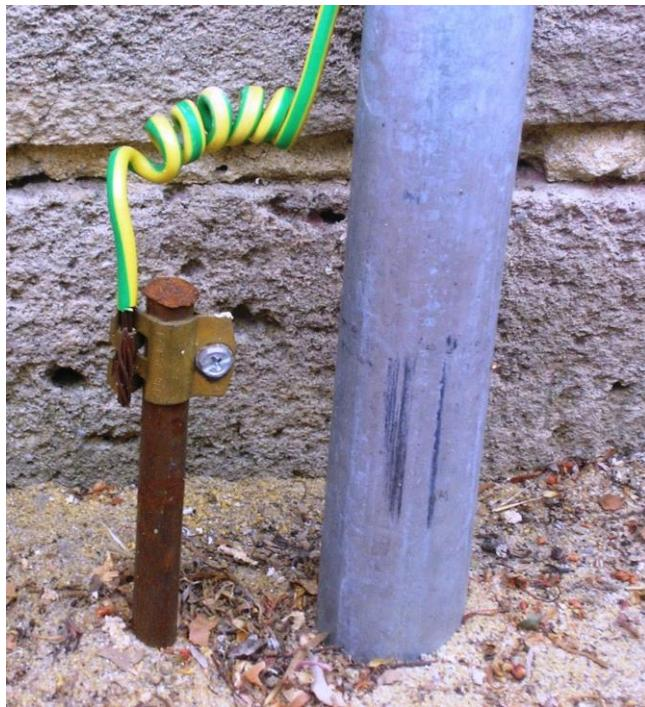
Slika 3.2. Tipični štapni uzemljivač ukopan u tlu [9]
