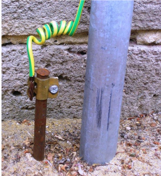
Slika 3.2. Tipični štapni uzemljivač ukopan u tlu [9]
