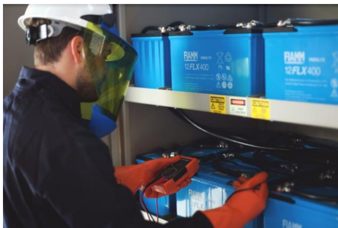
Slika 7.2. Mjerenje napona baterija za UPS [22]
