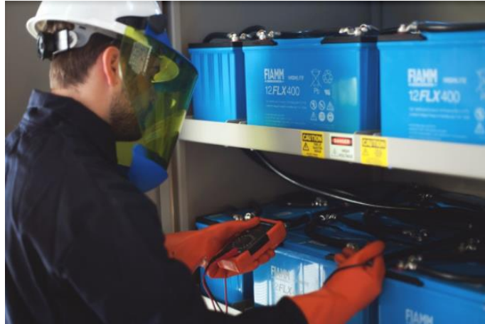
Slika 7.2. Mjerenje napona baterija za UPS [22]
