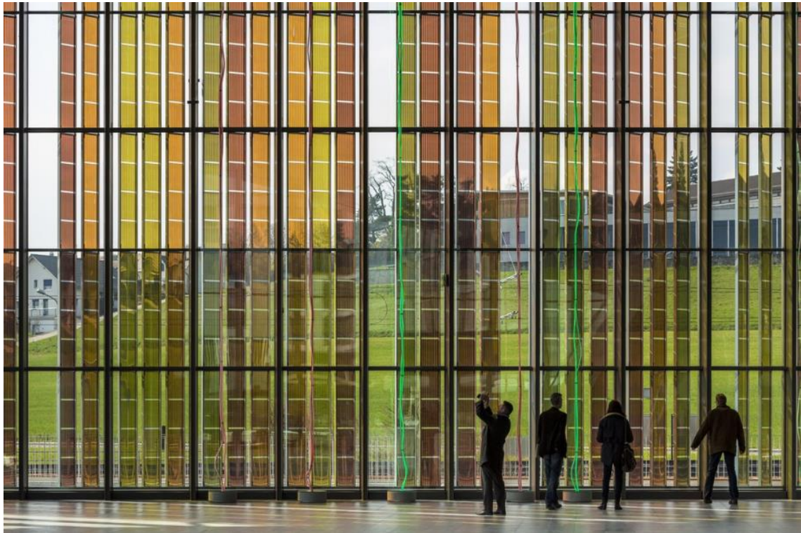
Sl. 2.5. Stakleni zid prekriven Dye-Sensitized fotonaponskim ćelijama [8]
