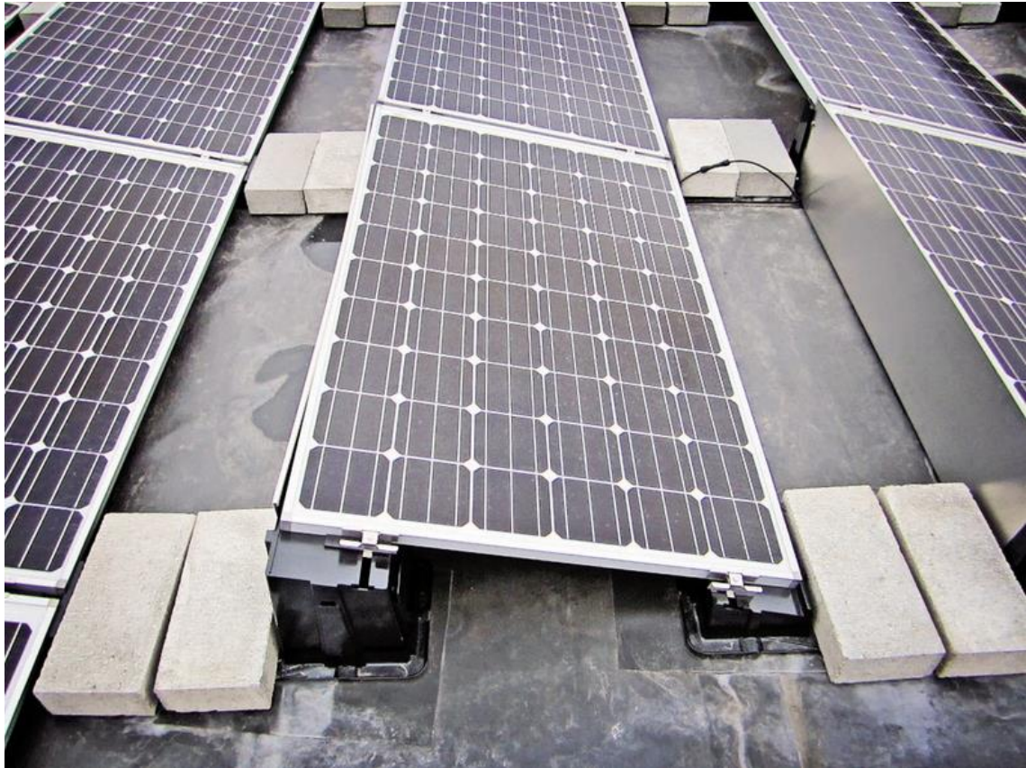
Sl. 2.12. Sustavi na ravnim krovovima; fotonaponski moduli montirani na plastičnu konstrukciju otežanu kamenim blokovima. [12]
