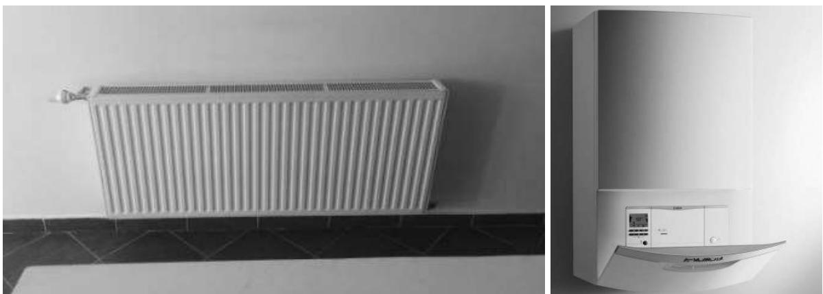
*Slika 5.1: Aluminijski pločasti radijatori i fasadni kondenzacijski bojler [12]*
