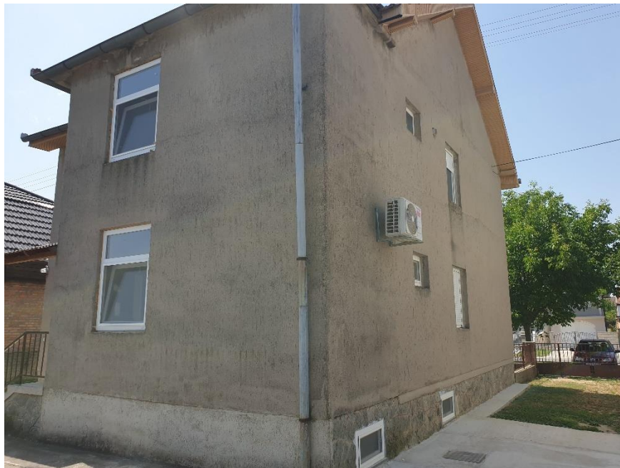
Slika 3.3. Sjeverno i zapadno pročelje obiteljske kuće.
