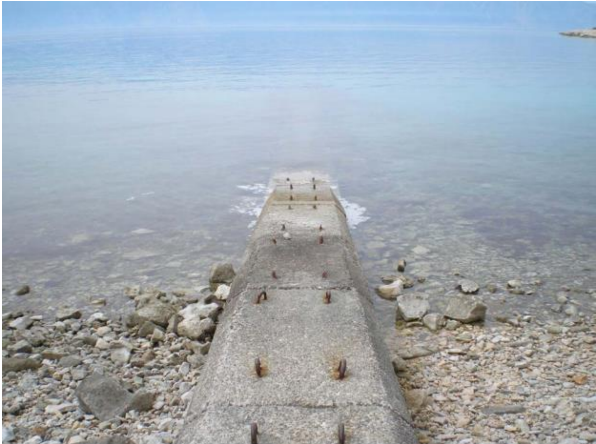
Slika 3.14. Priobalna zaštita 110 kV podmorskog kabela [11]
