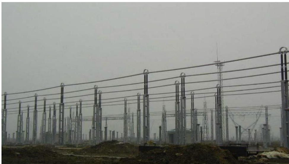
Slika 2.1. Cijevni vodiči [1]
