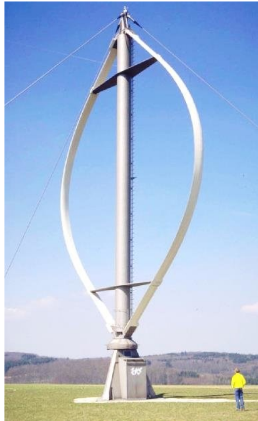
Slika 4. Vjetrogenerator s okomitom osi vrtnje [2]
