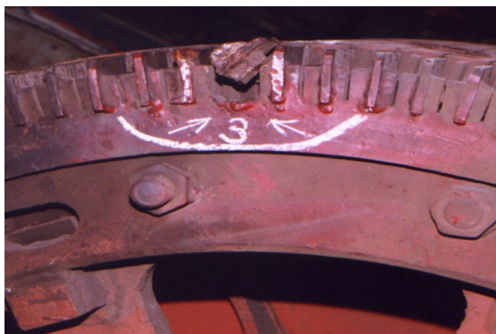
Slika 5.2. Oštećenje kaveznog rotora
