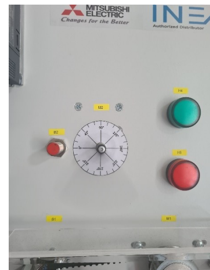
Sl. 4.17 Rad servomotora pri brzini vrtnje motora od 1000 r/min
