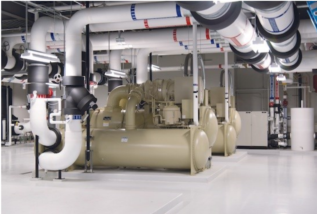
Slika 3.4.2. Prikaz vodom rashladnog uređaja u većim postrojenjima
