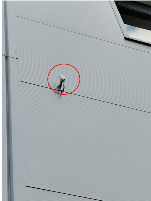
Slika 4.9. Senzor za rasvjetu
