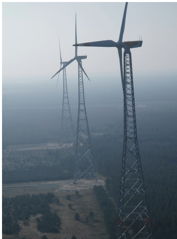
Slika 4.1.2.1. Primjer rešetkaste izvedbe stupa vjetroagregata [16]
