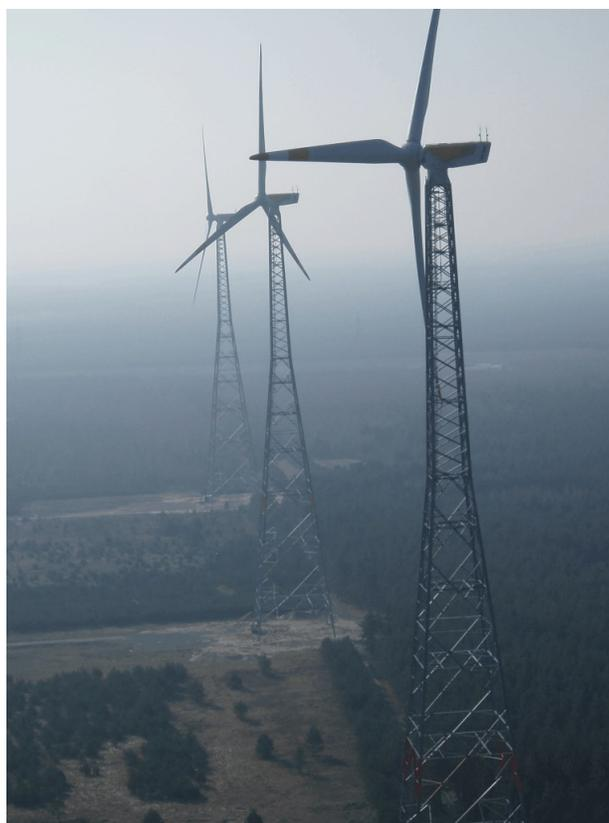
**Slika 4.1.2.1.** *Primjer rešetkaste izvedbe stupa vjetroagregata [16]*
