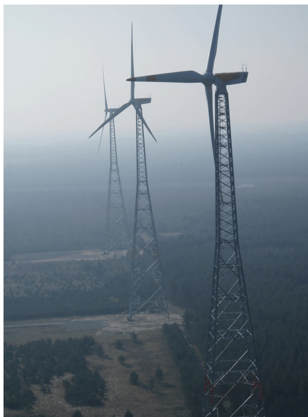
Slika 4.1.2.1. Primjer rešetkaste izvedbe stupa vjetroagregata [16]
