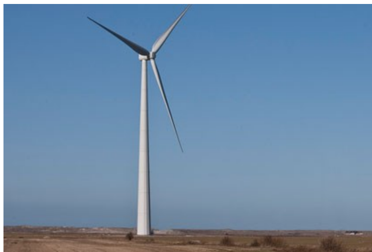
Slika 4.1.1.1. Primjer cijevne izvedbe stupa vjetroagregata [15]
