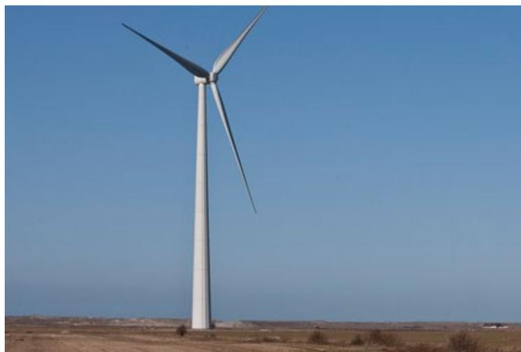
**Slika 4.1.1.1.** *Primjer cijevne izvedbe stupa vjetroagregata [15]*
