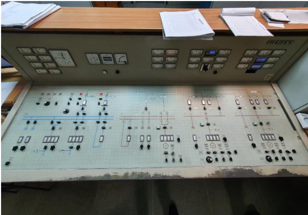
Slika 5.2. Komandni pult za daljinsko upravljanje (fotografirano 9. kolovoza 2022.)
