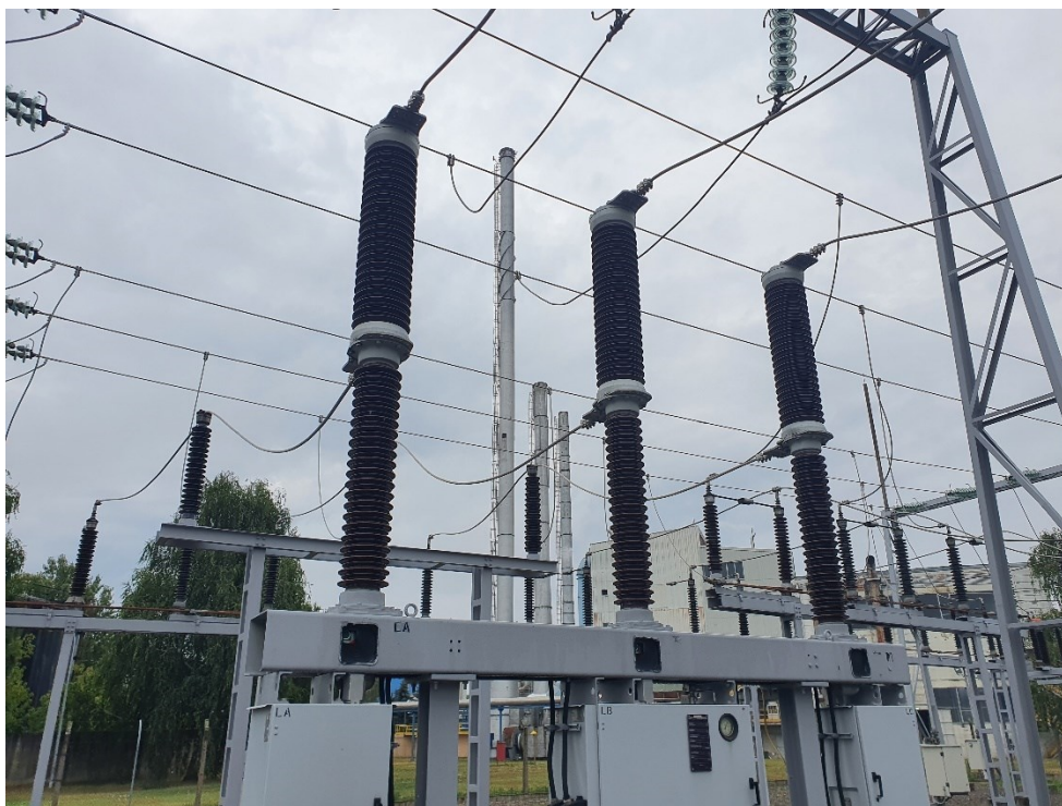
Slika 6.8. Odabrani SF 6 prekidač tip 3AP1FE(FG) (fotografirano 9.kolovoza 2022.)
