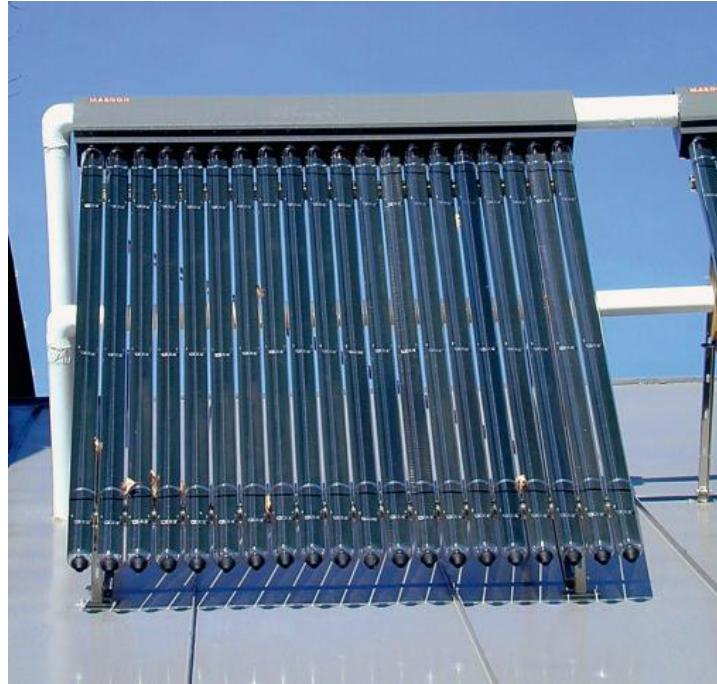
Slika 3.6.8. Vakumski cijevni kolektor [21].
