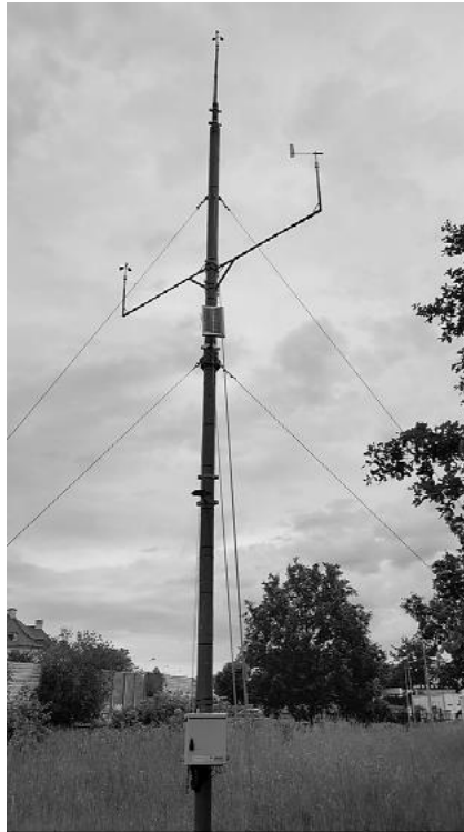
Slika 6.10 Mjerni stup u Koszalinu [23]
