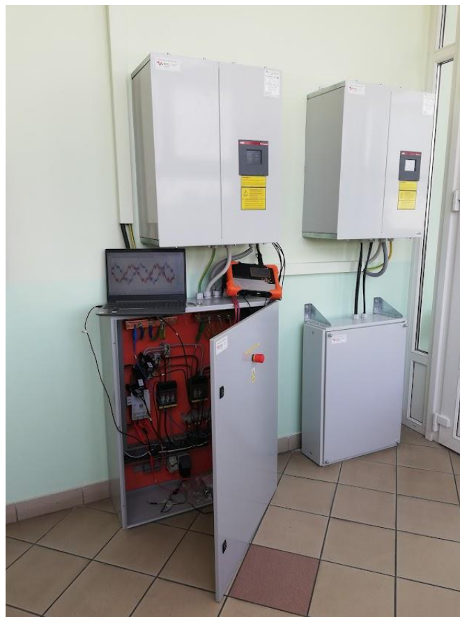
Slika 4.1. Aktivni filter (lijevo) i generator harmonika (desno)
