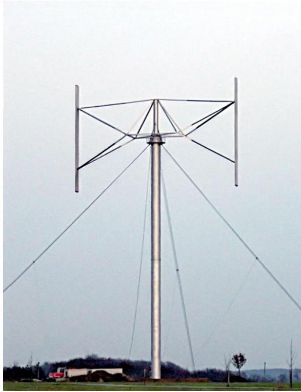
Sl. 4.5. Darrieusova turbina[15]
