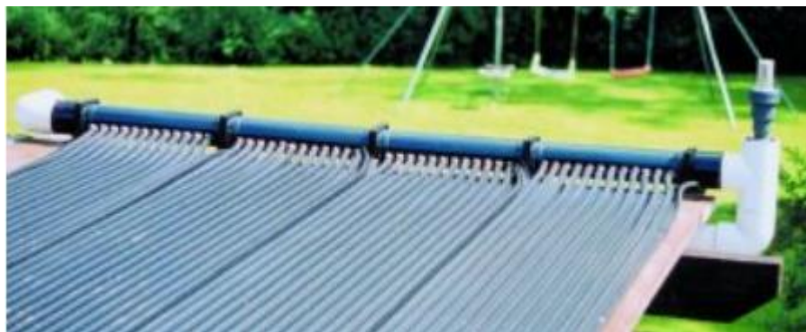
Slika 2.4. Neostakljeni apsorberi [1]
