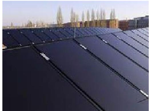
**Slika 3.8, Prikazuje tankoslojni kandijev telurid fotonaponski modul [20]**
