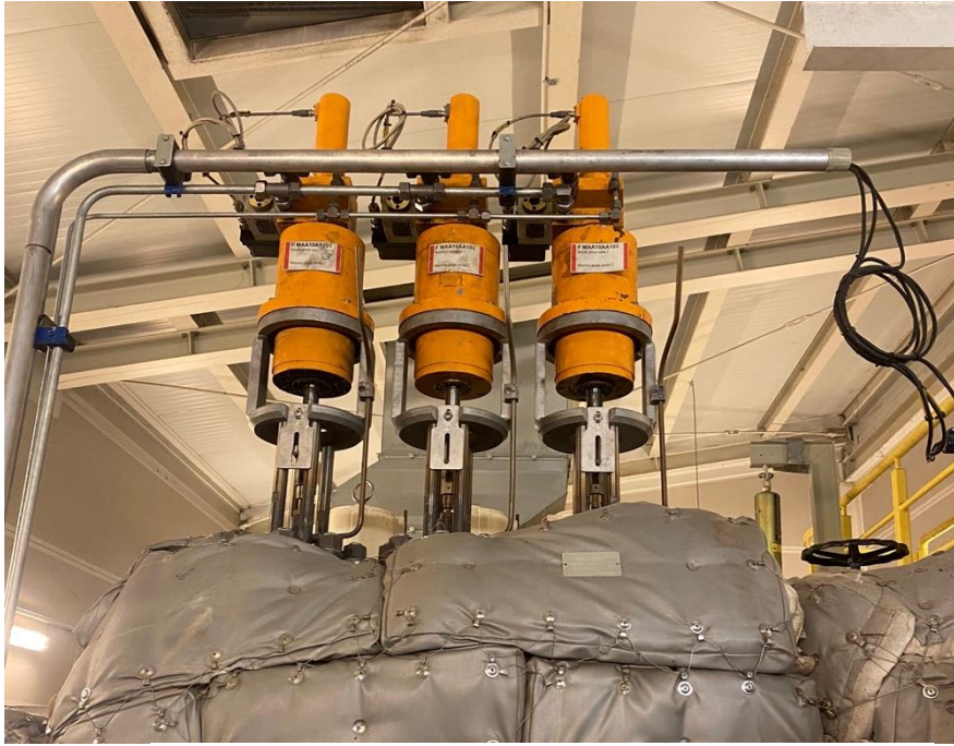
Slika 4.8. Brzo-zatvarajući ventili (fotografirano 10.siječnja 2023.)
