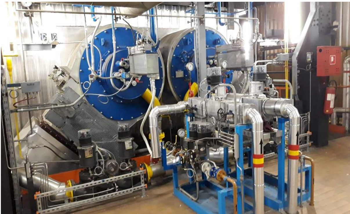
Slika 3.14.. Prikaz dva plemenika na nivou 2 (fotografirano 8.lipnja 2022.)
