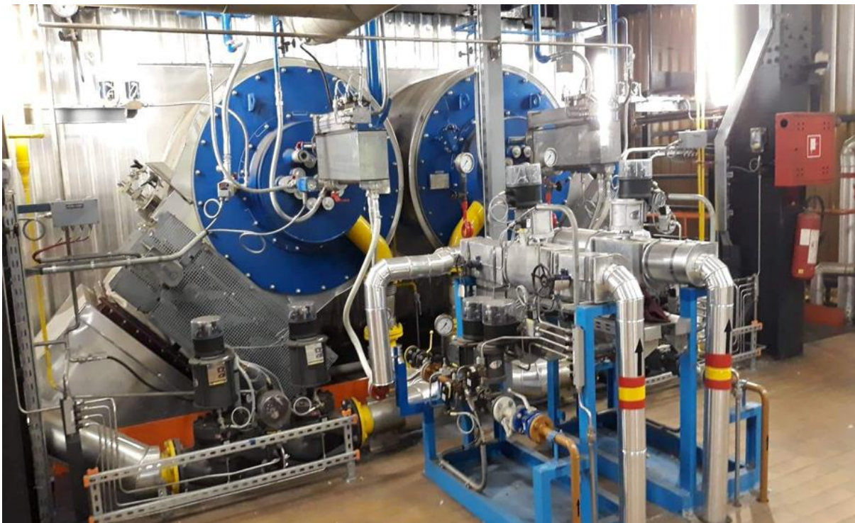
Slika 3.14.. Prikaz dva plemenika na nivou 2 (fotografirano 8.lipnja 2022.)
