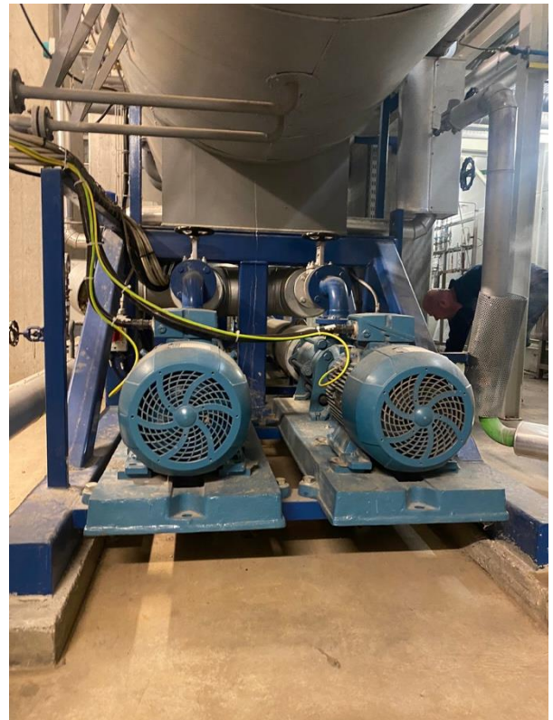
Slika 4.10. Pumpe kondenzatora (fotografirano 10.siječnja 2023.)
