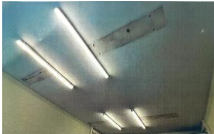
Slika 5.12. Nova LED rasvjeta neposredno nakon instalacije
