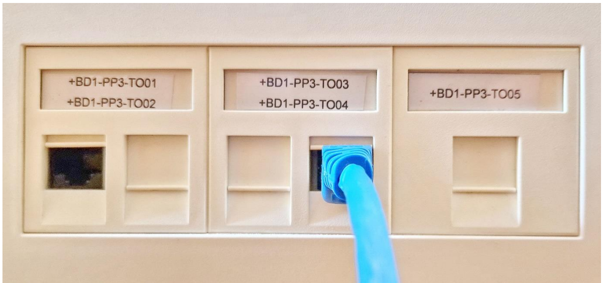
Slika 3.2 Primjer označavanja RJ45 priključnica u prostorijama
