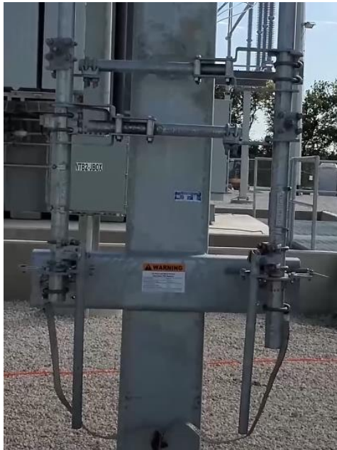
Sl. 4.1. Mehanički blokirane ručke uzemljenja [8]
