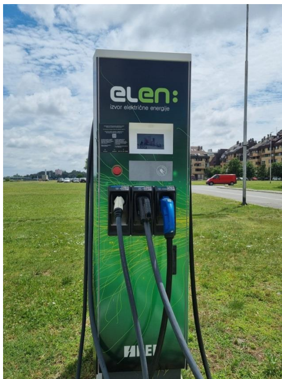
Slika 3.1.: Punionica električnih vozila
