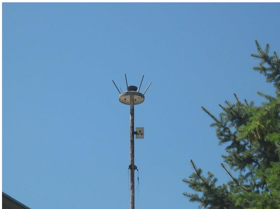
**Slika 4.5.** Radioaktivni gromobran
