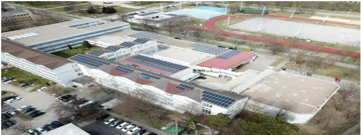
Slika 1.2 Fotonaponska elektrana u mikromreži FERIT 1 [2]
