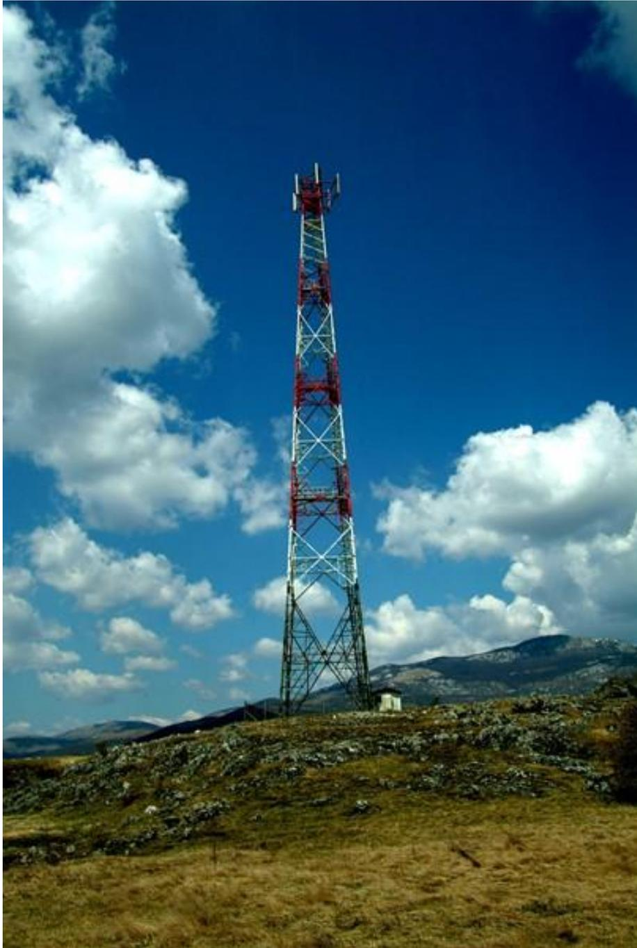
Slika 3.3. Rešetkasti antenski stup [9]
