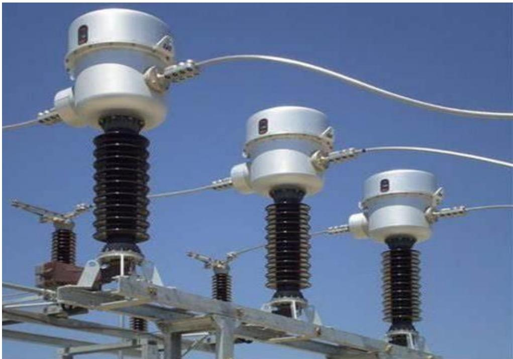
**Slika 3.4.** Strujni mjerni transformator montiran na potpornom izolatoru [6]
