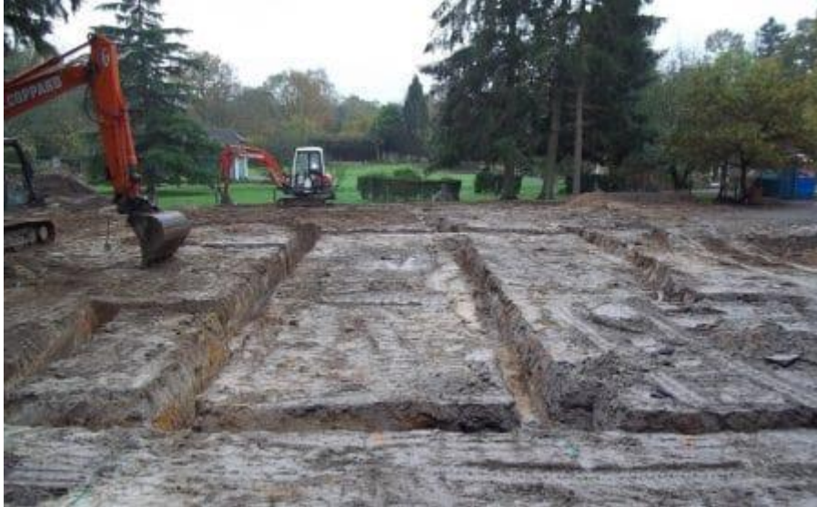
Slika 3.2. Metoda postavljanja mrežastih uzemljivača u jarak.
