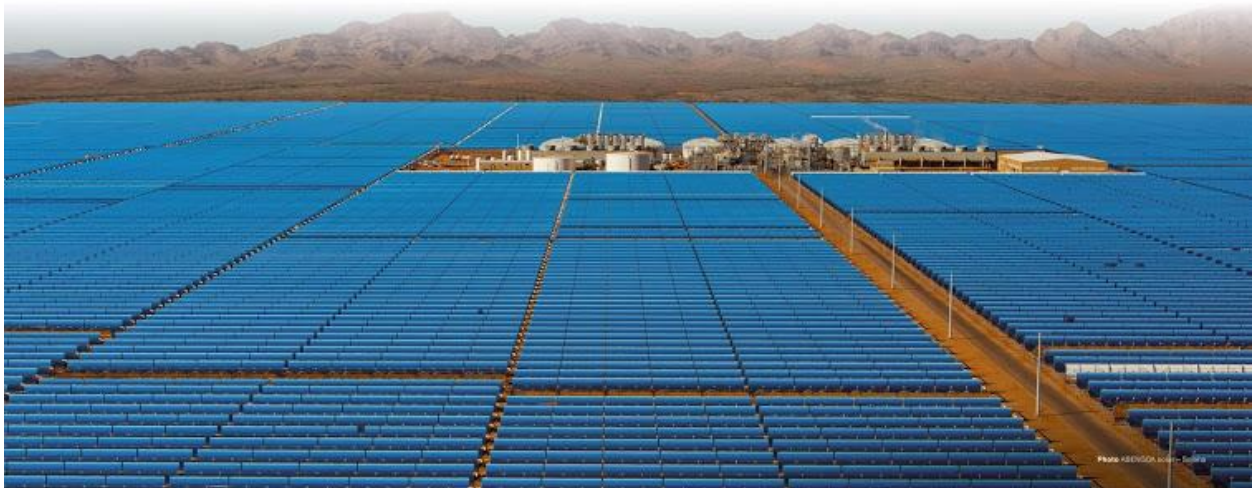
Sl. 4.5. Slika solarne termoelektrane SOLANA u Arizoni[13].
