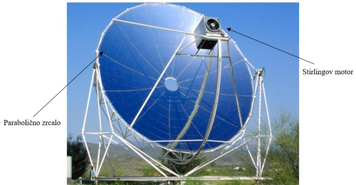
Sl. 7.1. Slika solarne termoelektrane s tanjurastim kolektorom[23].
