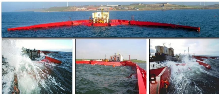
Slika 2.3 WaveDragon – primjer završnika. Reproducirano uz dopuštenje od [8]
