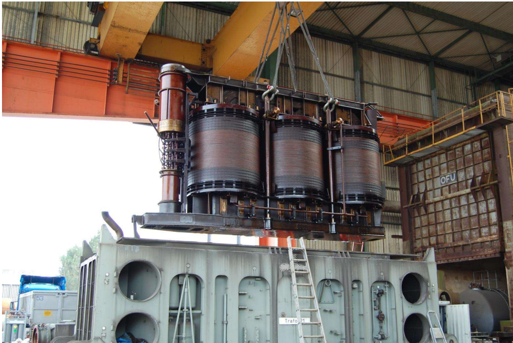
Sl. 2.5. Uranjanje namota jezgre i namota transformatora u kotao. [17]
