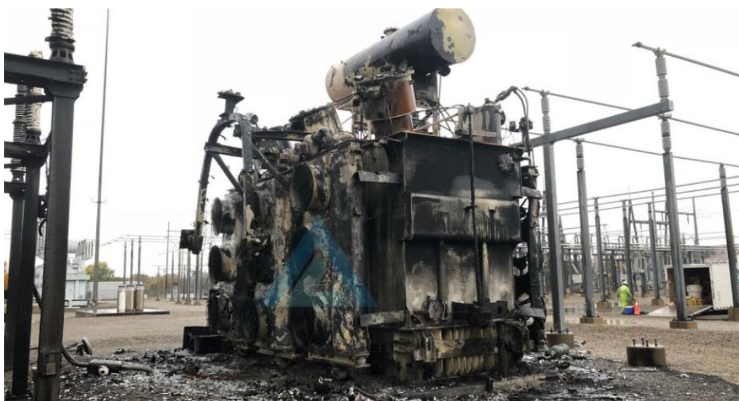
Slika 3.1. Posljedice kasnog reagiranja na kvar kratko spojenog kruga u jezgri
