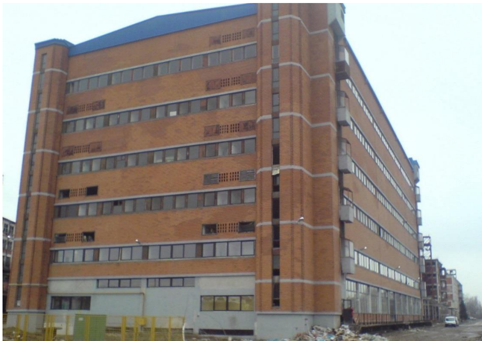
Slika 3.1. Zgrada obućare s južne strane prilikom obnove 2009. godine [9]
