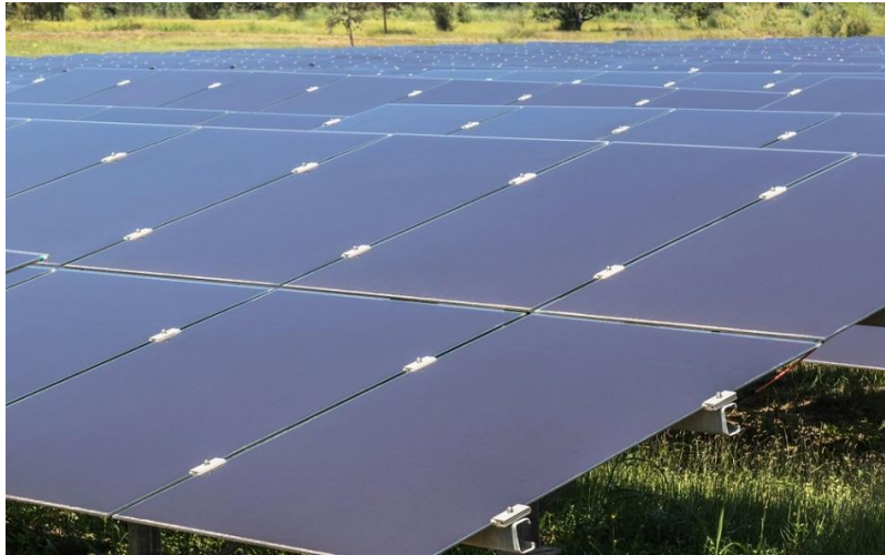
Slika 2.9. CdTe solarni moduli, [6]
